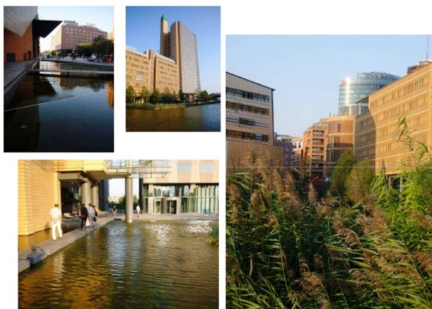
Berlino - Postdamer Platz - Vasca di accumulo e volano per acque di pioggia
